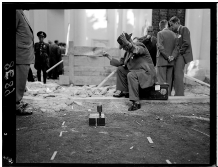
Kuno Tesman con su péndulo. (CdF, Centro de Fotografía de Montevideo, Intendencia de Montevideo).
